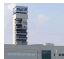
Testy długości instalacji
